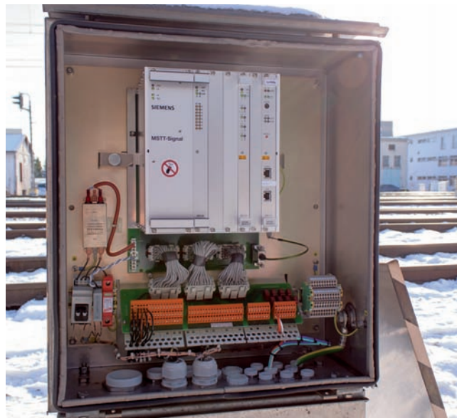
Obr. 1 Riadiaca jednotka svetiel hlavného návěstidla obsahujúca modul riadenia svetiel a modul LEU
