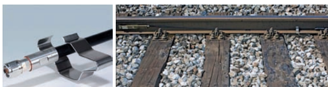
Obr. 3 Koaxiálny kábel euroslučky a jeho upevnenie na päte koľajnice. Zdroj [7]
